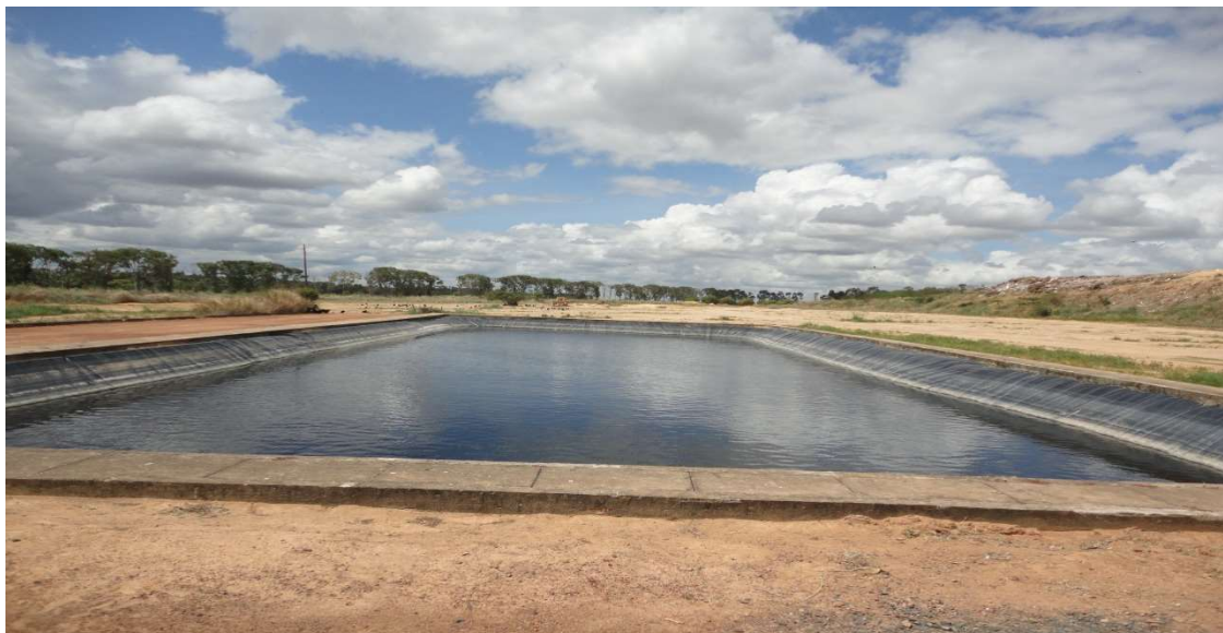
Figura 2. Vista da Estação de Tratamento de Chorume – ETC, por meio de lagoa anaeróbica do aterro sanitário de Boa Vista/RR.
