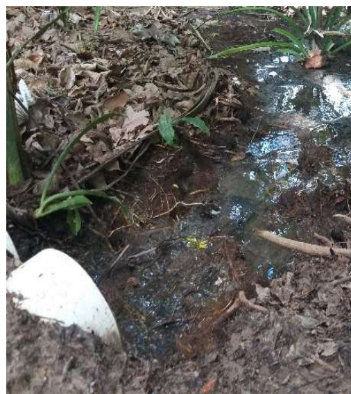
Figura 6. Despejo irregular de esgoto nas delimitações internas do Parque do Cocó
