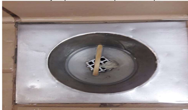
Figura 7. Tubulação presente em quase toda parte da unidade fabril
